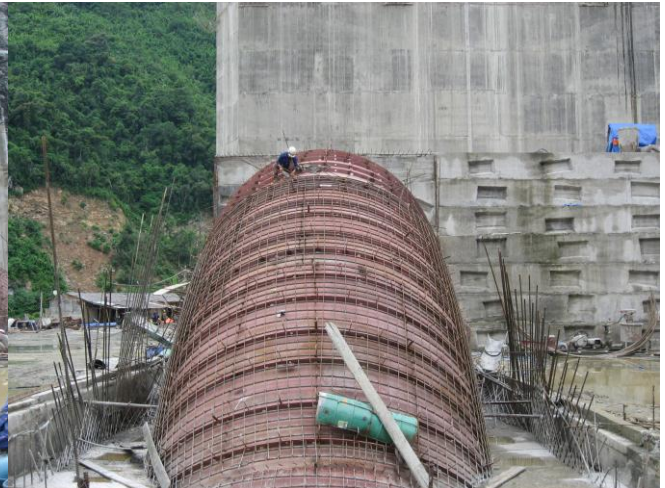
Chế tạo đường ống áp lực cửa ra tổ máy – Thủy điện Bản Vẽ
