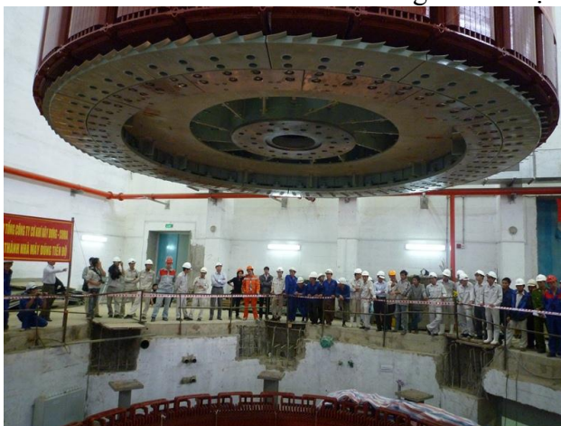
Công trình Thủy điện Bản Vẽ
