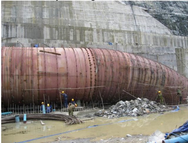
Chế tạo đường ống áp lực cửa ra tổ máy – Thủy điện Bản Vẽ
